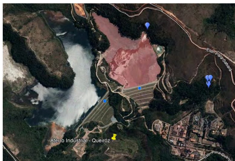
Figura 2-1: Vista geral da área em estudo.
