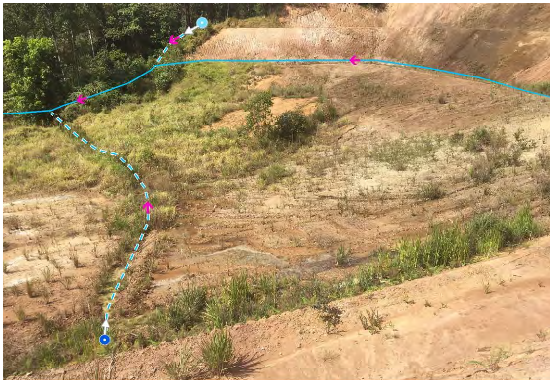
Figura 10 - Detalhe do ponto de surgência em cota inferior na área de empréstimo.
