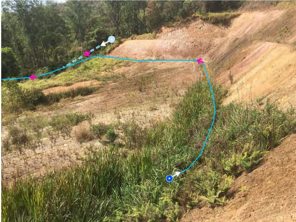
Figura 9 - Detalhe do ponto de surgência em cota superior na área de empréstimo.
