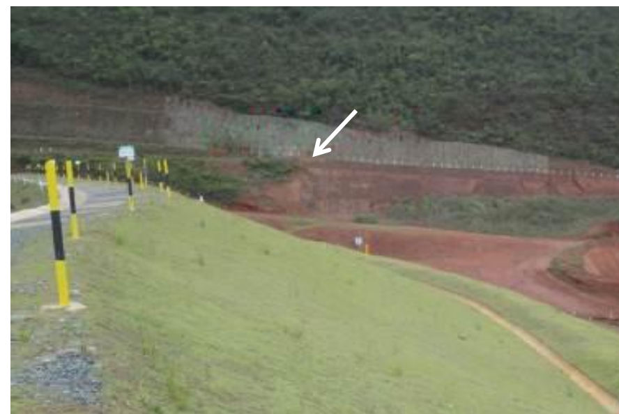
Foto 04 – Estrada de acesso à comunidade de Carrapatos, inserida no distrito de Barra Feliz que será relocada
