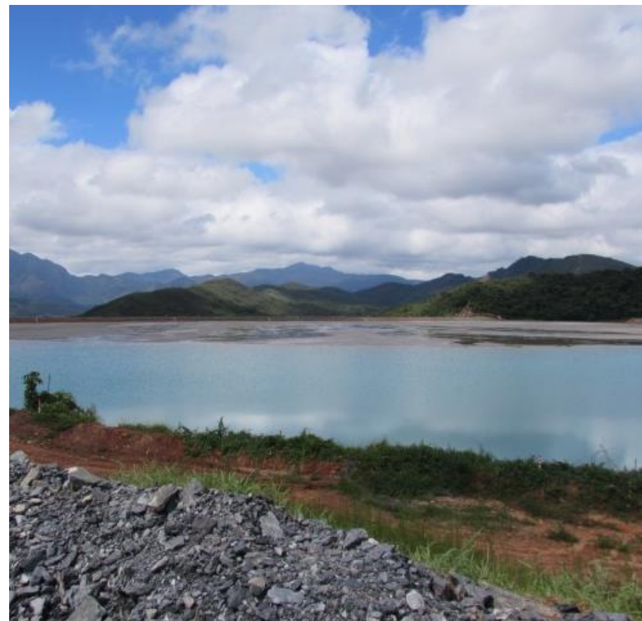
Foto 02 – Barragem de Rejeitos de CDSII
