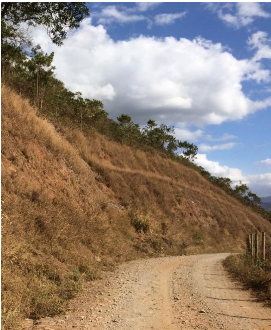
Foto 06 – Estradas (acessos) não pavimentadas, nos limites da ADA
