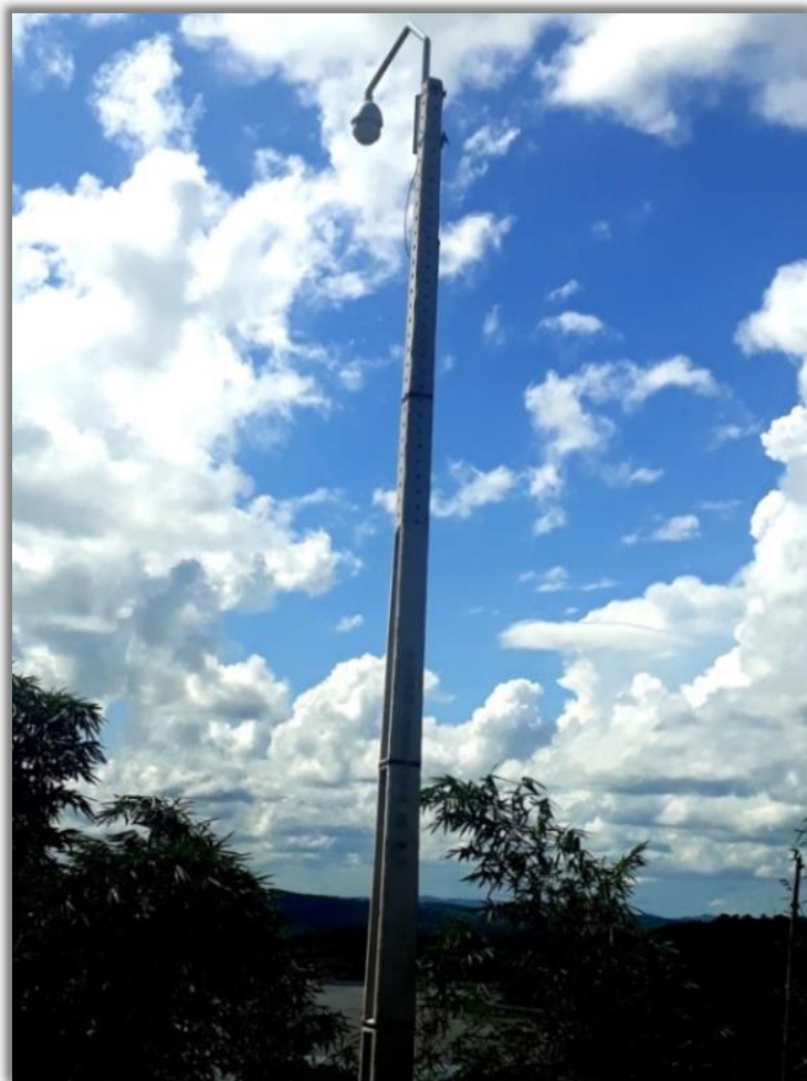
Figura 13-2: Câmera instalada ao lado da estação meteorológica, fora da influência da barragem
