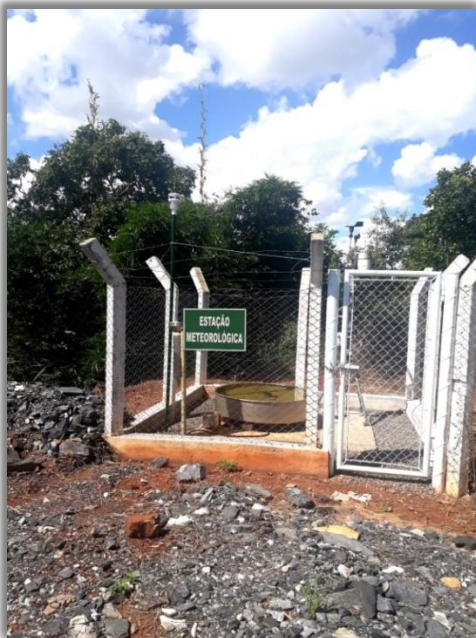
Figura 13-10: Vista da estação meteorológica
