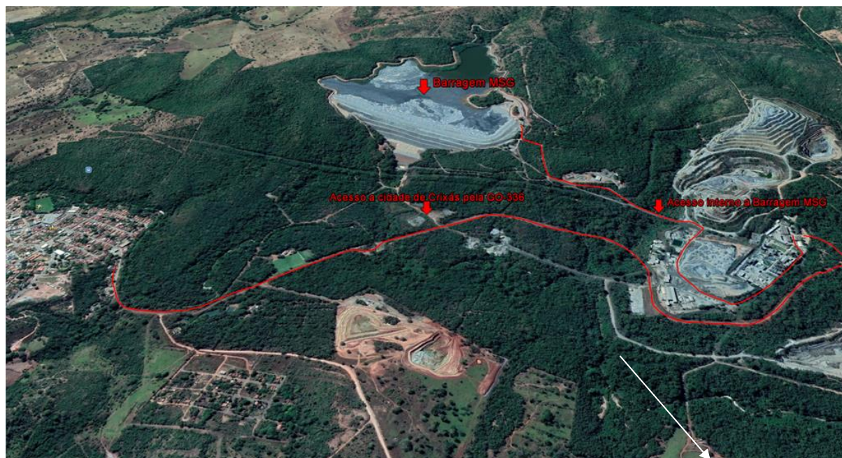
Figura 3-2: Vista geral da barragem e área a jusante com acessos
