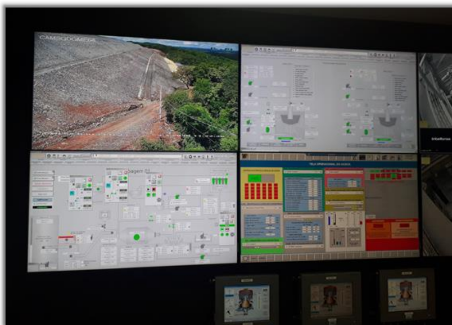
Figura 13-4: Imagem das câmeras instalada no prédio da Planta Metalúrgica
