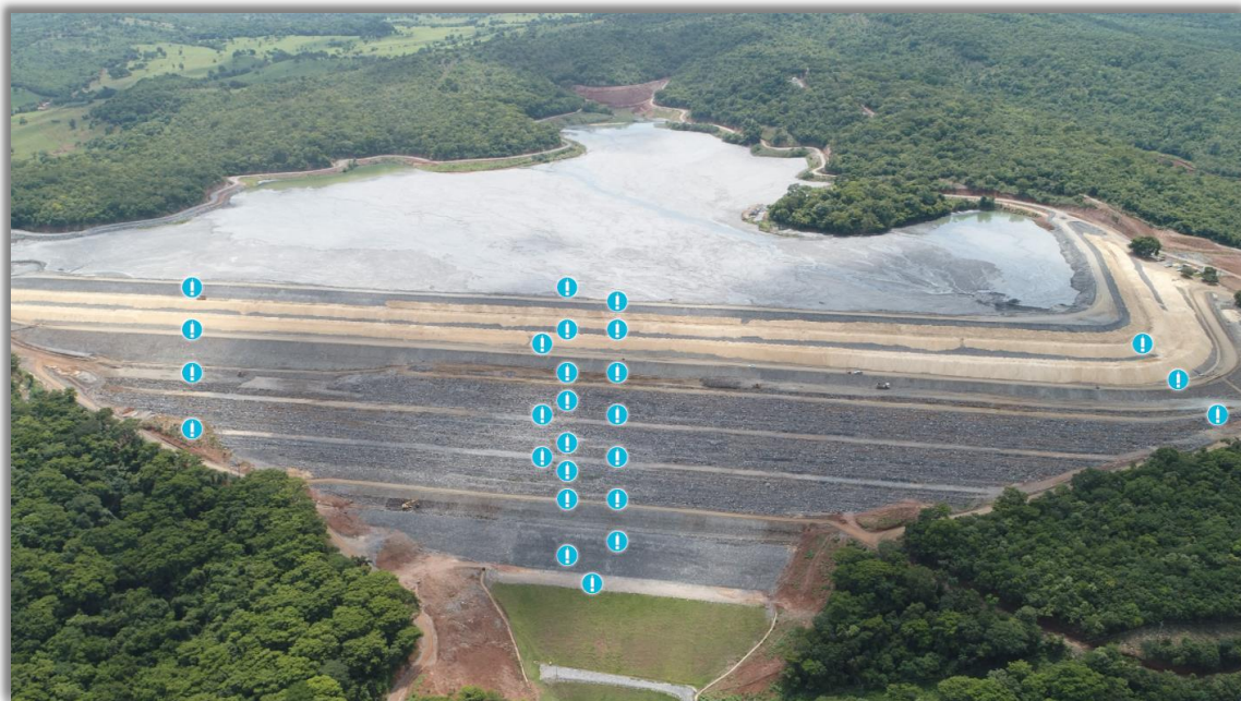
Figura 13-6: Tela de monitoramento dos piezômetros automatizados mostrando o posicionamento dos piezômetros automáticos
