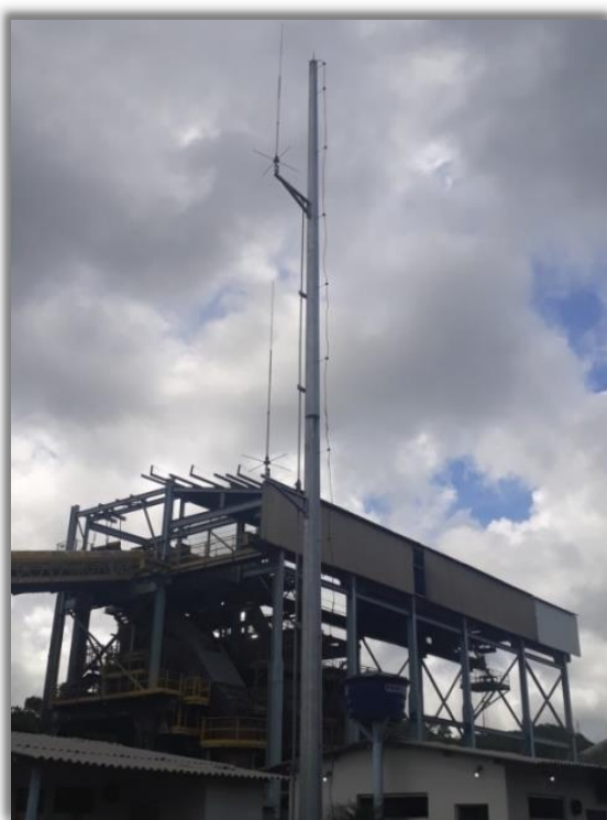
Figura 13-14: Torre repetidora localizada ao lado da sala de controle
