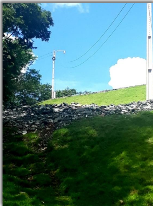
Figura 13-3: Câmera instalada no corpo da barragem para verificação da estrutura a jusante e da fundação da barragem
