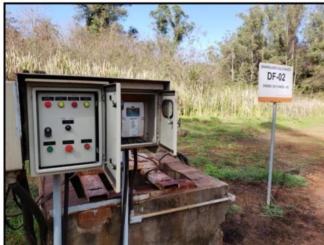
**Figura 13-5: Bombeamento da água de dreno do fundo, medida da vazão - barragem de Calcinados**
