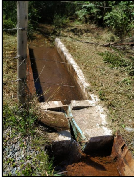
Figura 13-2: Medidor de Vazão de dreno de fundo – barragem Cocoruto
