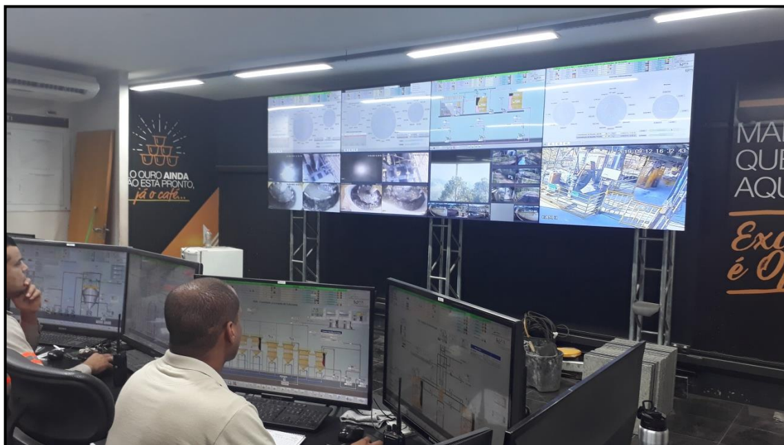
Figura 8-1: Sala de Controle
