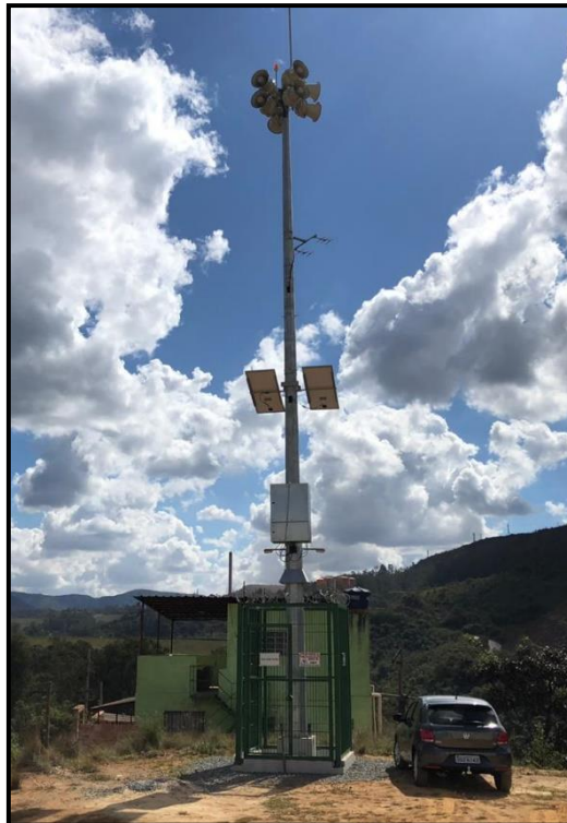
Figura 8-5: Dispositivo fixo de advertência sonora – Torre 1 – Fornecedor Tecal
