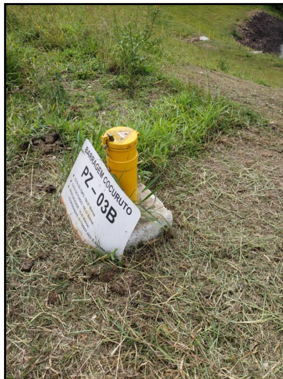
Figura 10 –Piezômetro PZ-03B - barragem Cocoruto
