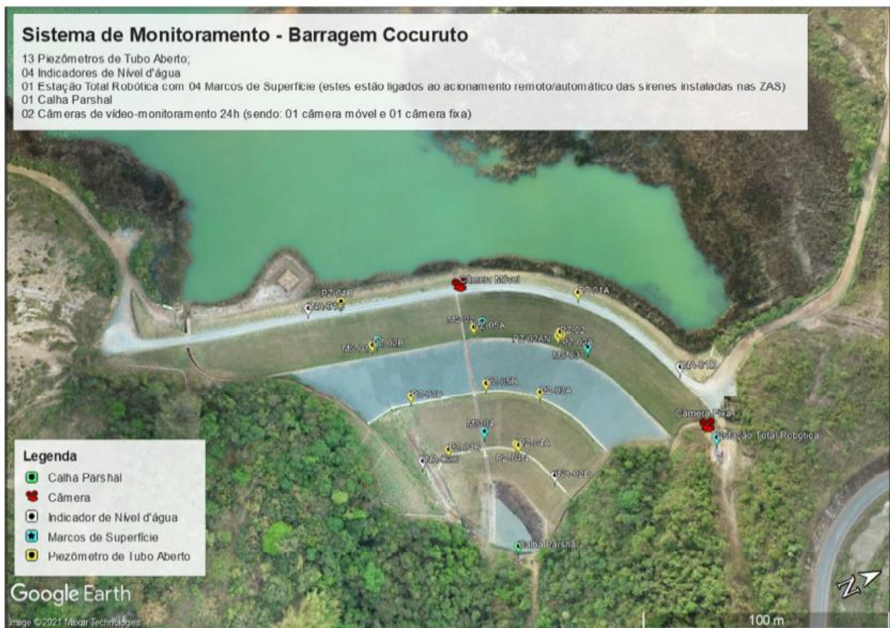
Figura 13-1: Sistema de Monitoramento – Barragem Cocoruto
