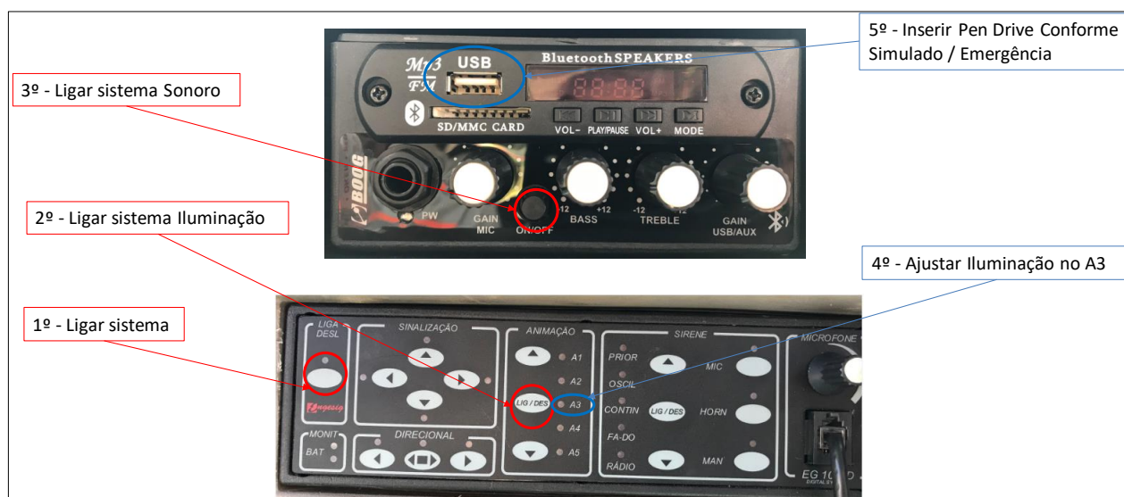
Figura 8-11: Acionamento do sistema de sirenes no veículo de apoio.
