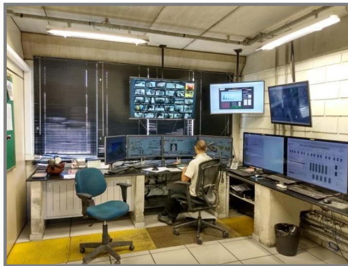
Figura 13-2: Visão geral da sala de controle da Planta de Cuiabá
