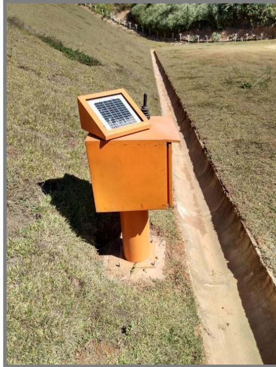
Figura 13-8: Piezômetro automatizado instalado no corpo da barragem
