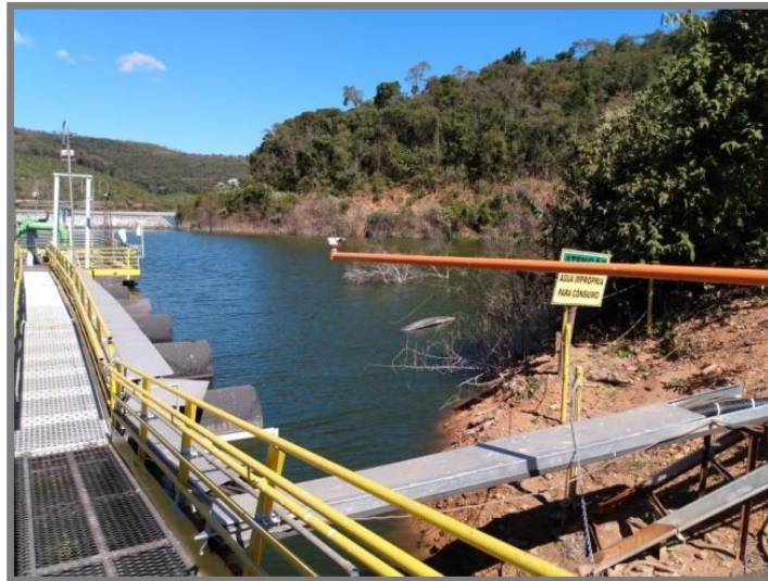
Figura 13-10: Medidor de nível d'água do lago
