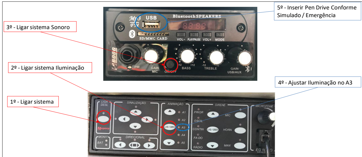
Figura 8-11: Acionamento do sistema de sirenes no veículo de apoio.
