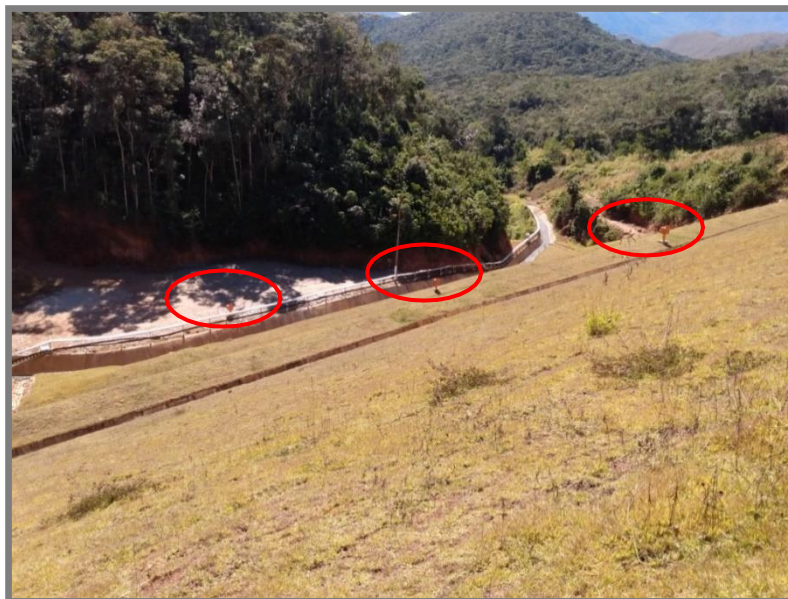
Figura 13-9: Piezômetro automatizado instalado na fundação da barragem
