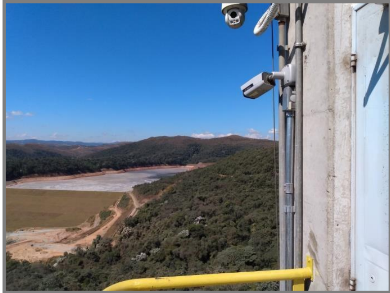
Figura 13-4: Câmera externa com visão geral da estrutura
