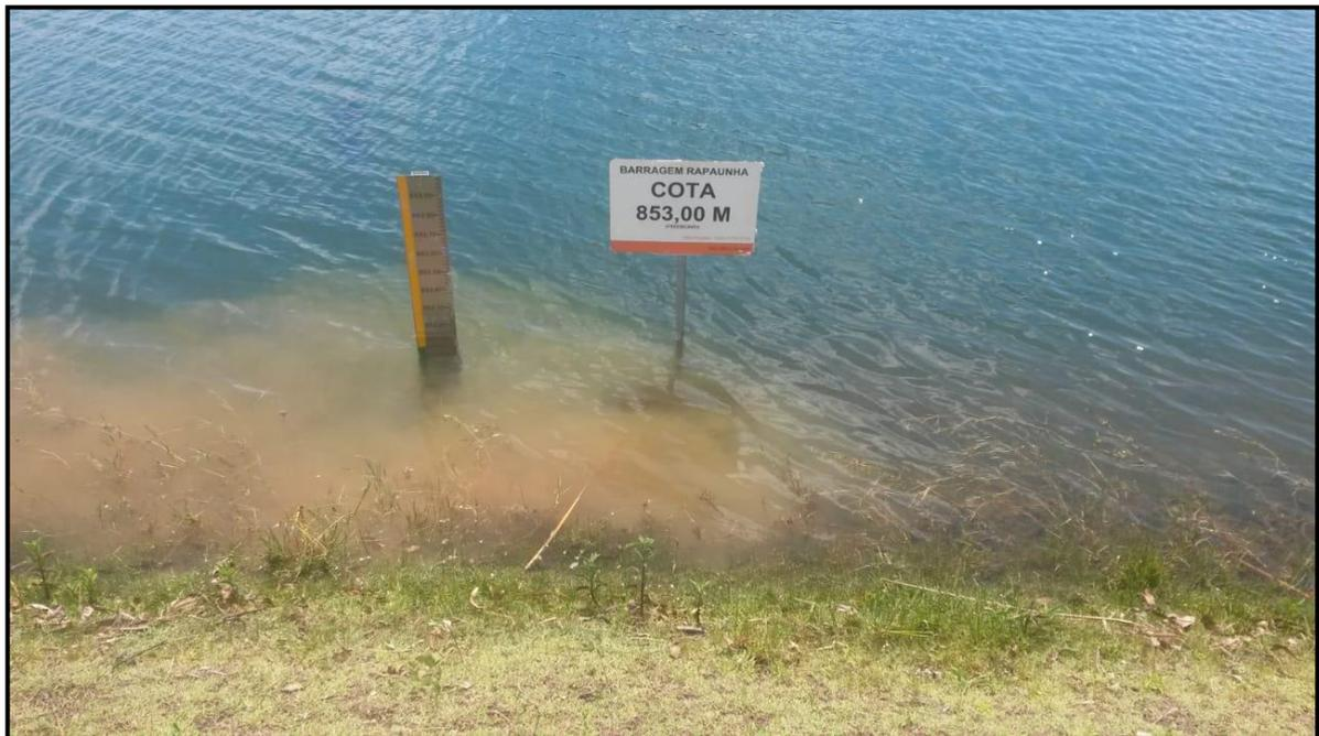
**Figura 13-3: Régua graduada instalada no reservatório - barragem Rapaunha**
