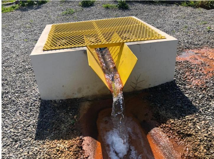
**Figura 13–2: Medidor de Vazão de dreno de fundo – barragem Rapaunha**
