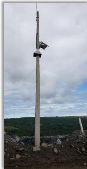
Figura 13-6: Torre de transmissão do sinal dos instrumentos automatizados
