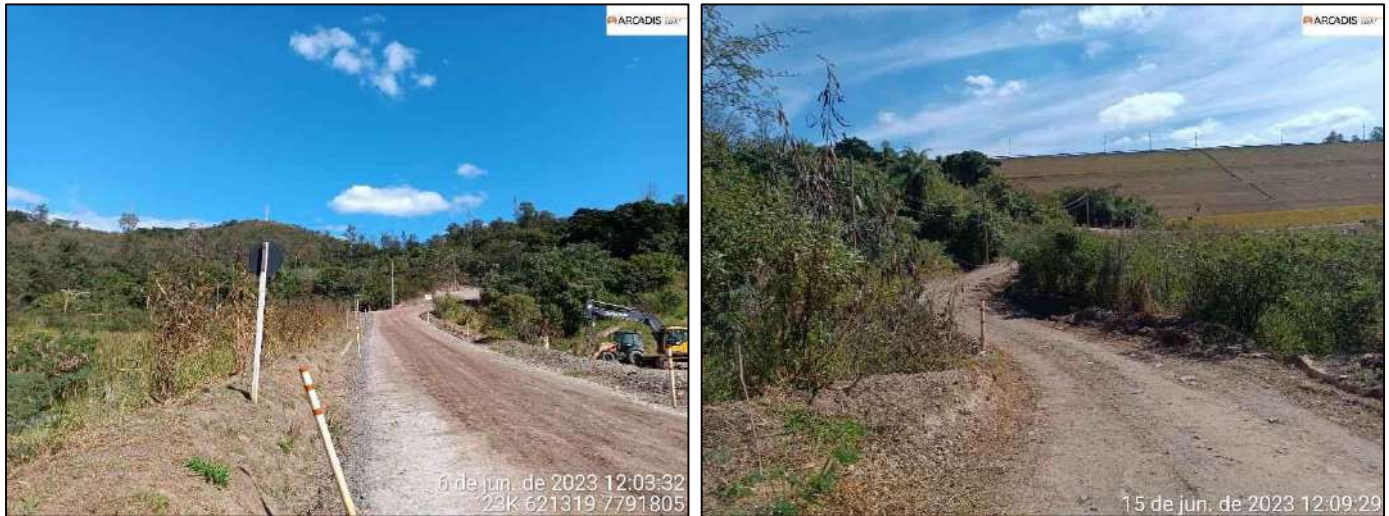
Figura 12-52 - Visão geral dos locais classificados como Vias de acesso na área estudada (esquerda e direita)
