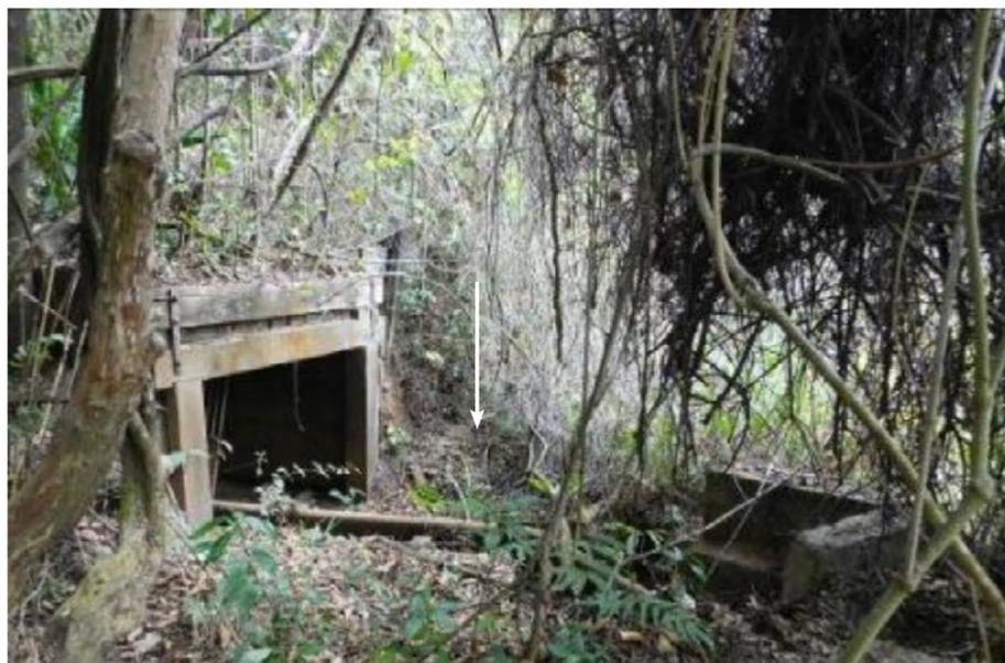
VISTA DA MINA (À ESQUERDA) E CAIXA DE PASSAGEM DE CONCRETO (À DIREITA). A SETA INDICA A TUBULAÇÃO DE FERRO QUE CORRE SUSPENSA AO CANAL ESCAVADO NO SOLO.
