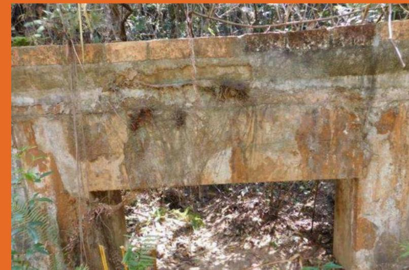
VISTA DO AQUEDUTO 1.2, ONDE SEU LEITO, AO INTERCEPTAR UM CANAL PLUVIAL, FOI ELEVADO POR UMA PONTE EM ALVENARIA ESTRUTURAL DE TIJOLOS DE CONCRETO. O REFORÇO DE AMBAS AS BORDAS FOI FEITO COM UMA FILEIRA DE TIJOLOS CERÂMICOS MACIÇOS SEM REVESTIMENTO.
