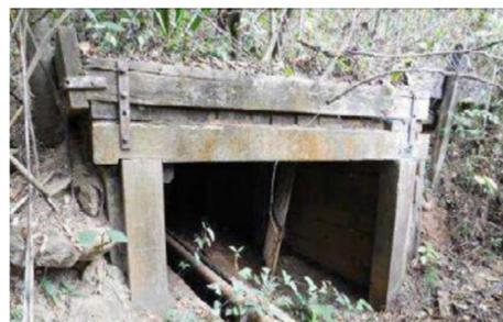
ENTRADA DA MINA SUSTENTADA POR PILARES E VIGAS DE MADEIRA PRESAS ENTRE SI POR CHAPAS DE FERRO E REBITES. DESTACA-SE O CANAL ESCAVADO NO PISO E O TUBO DE FERRO.
