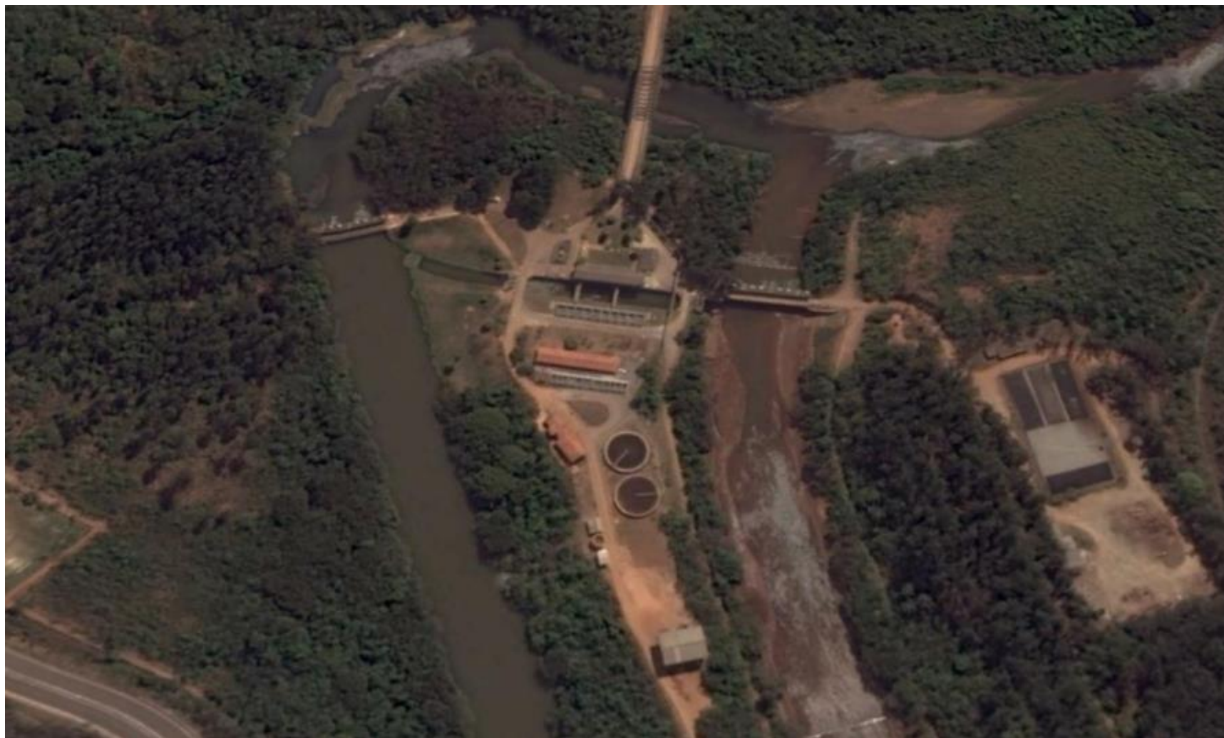
Figura 5: Captação de Água no Rio das Velhas
