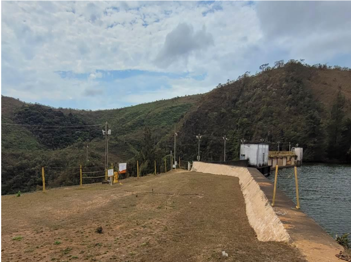
Figura 11: Vista parcial do talude de jusante da barragem. Notar instrumentação existente.
