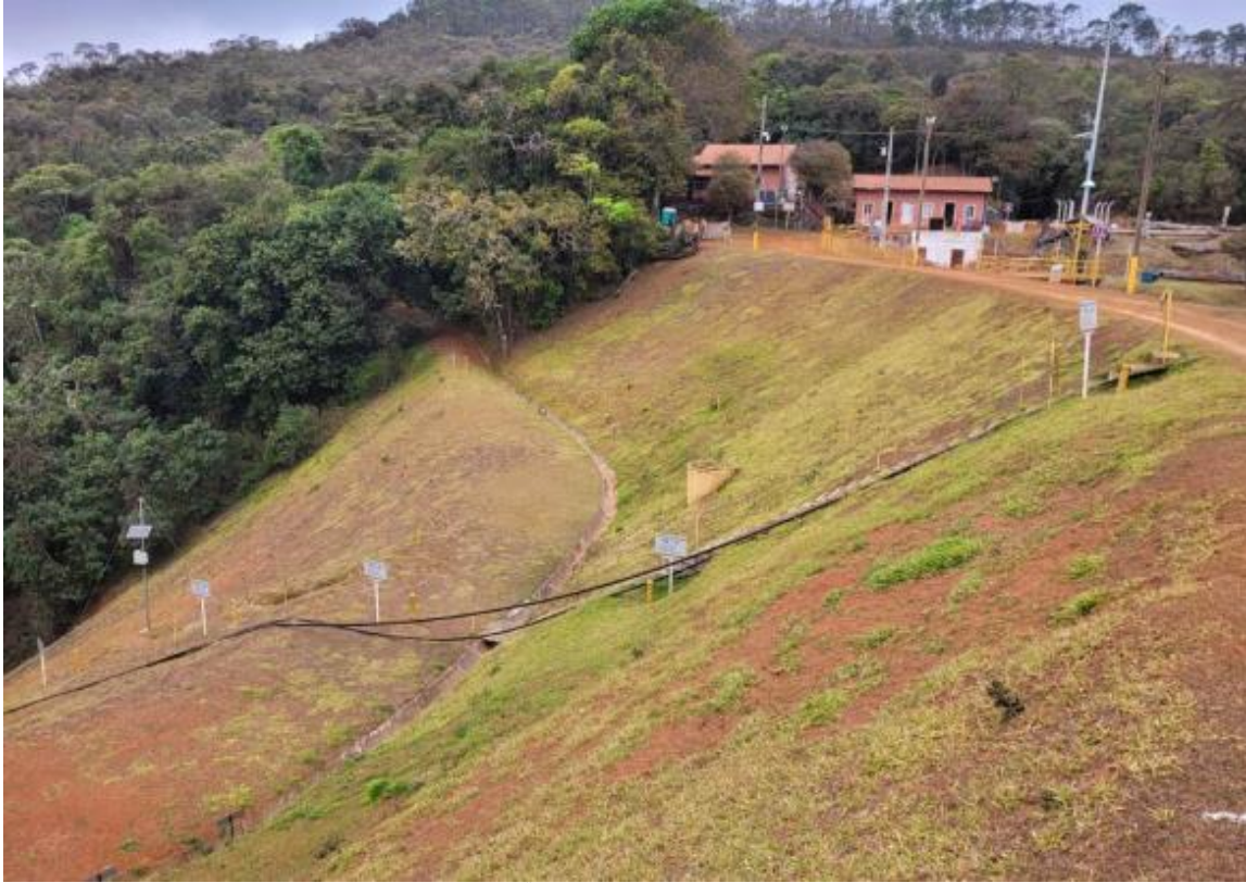
Figura 12: Vista parcial do talude de jusante da barragem. Notar instrumentação existente.
