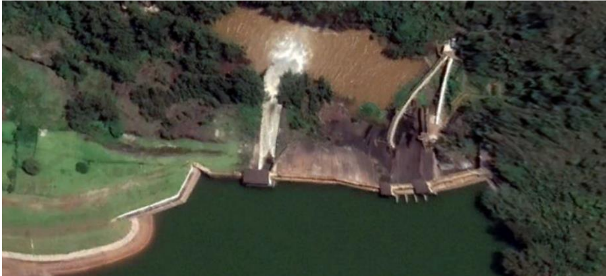
Figura 11: Barragem Codorna proprietário Anglogold, coordenadas: latitude -20.165555, longitude: -43. 890152
