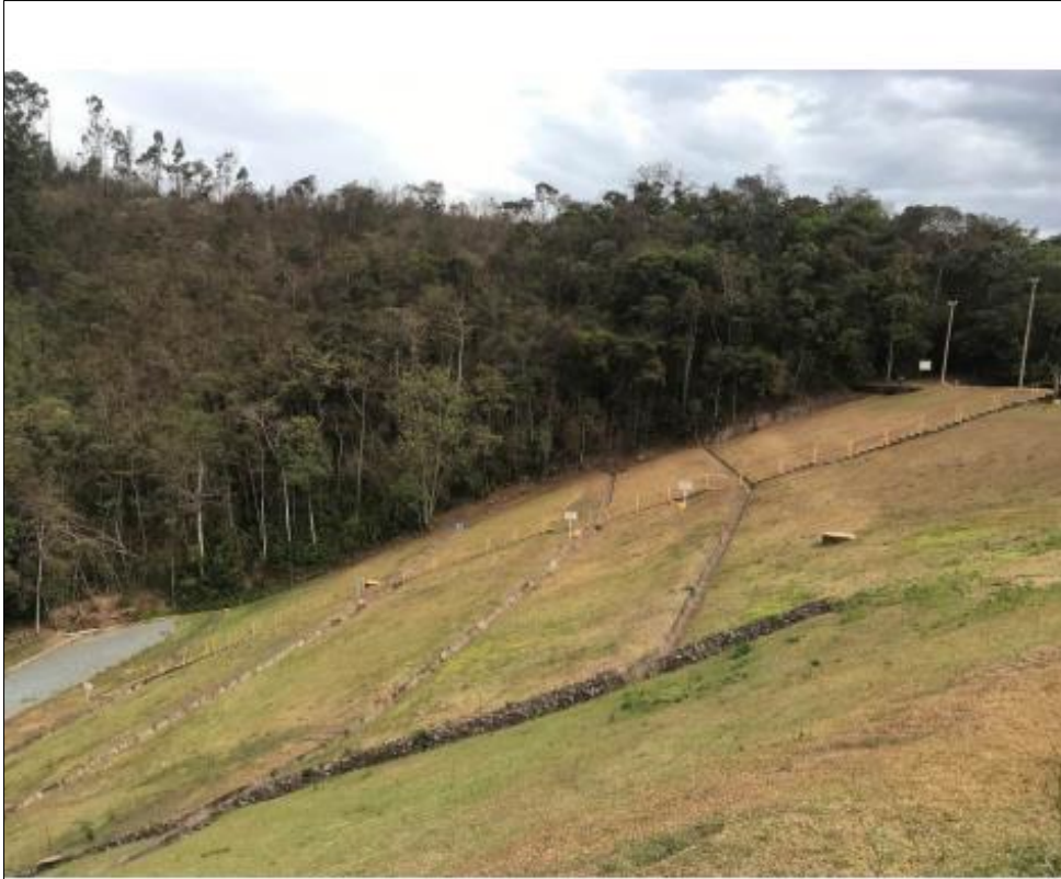
Figura 11: Vista parcial do talude de jusante da barragem. Notar instrumentação existente. .
