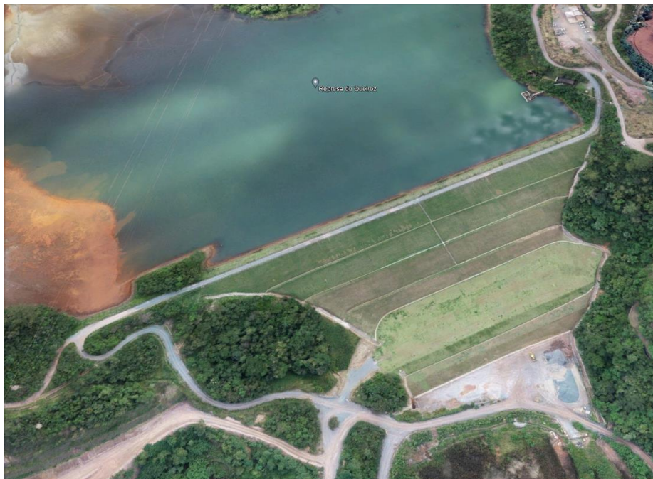
Figura 1: Vista aérea da Barragem Rapaunha
