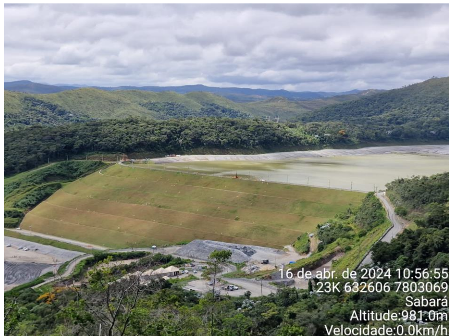
Figura 1: Vista aérea da Barragem Cuiabá
