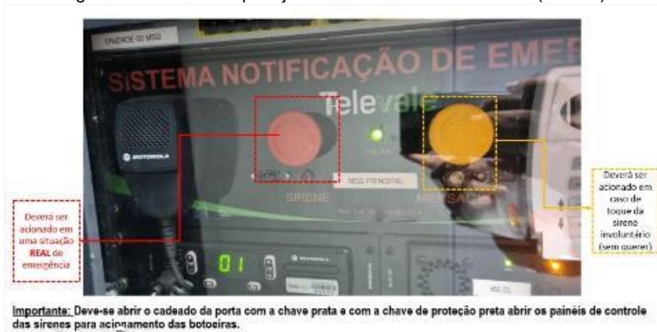
Fonte: Manual de Operação e Manutenção do Sistema Notificação de Emergência (AA-162-TL-5287-604-MA-0001\_4)
