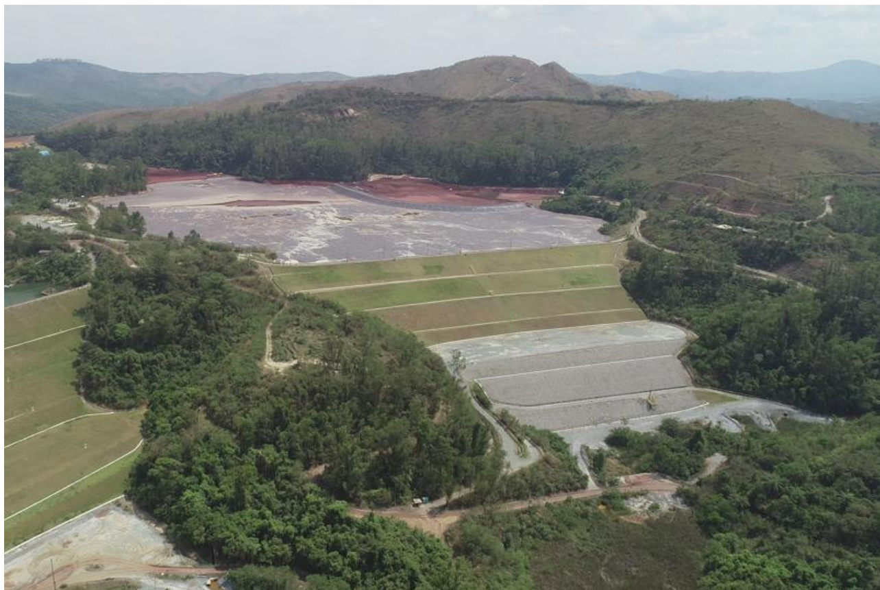
Figura 1: Vista aérea da Barragem Calcinados
