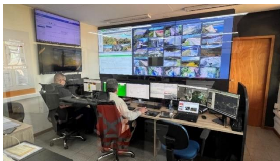
Figura 7: (CMG) Centro de Monitoramento Geotécnico de Barragens em operação.
