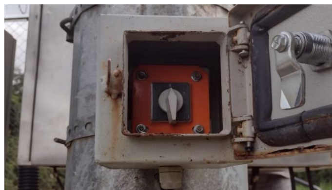
Figura 5: Botoeira de Acionamento Manual Torres Tecal
