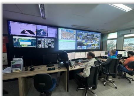
Figura 7: (CMG) Centro de Monitoramento Geotécnico de Barragens em operação.
