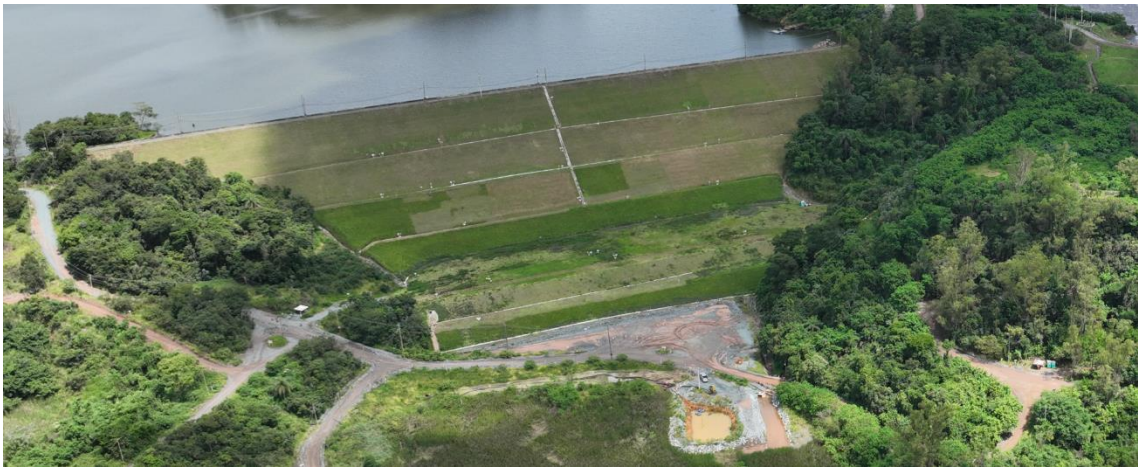
Figura 1: Vista aérea da Barragem Rapaunha
