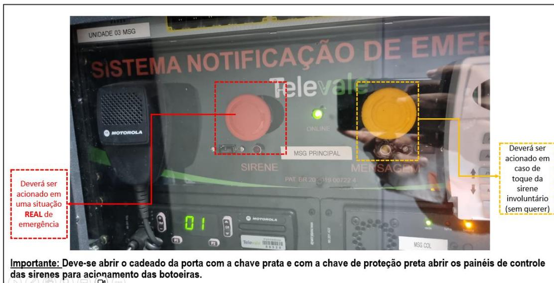
Este sistema trabalha com uma unidade redundante e todo o sistema permite o acionamento remoto a partir da Central de Monitoramento. Em caso de indisponibilidade de alguma sirene, a equipe de manutenção do sistema é informada e acionada imediatamente para correção do problema. Preventivamente, falhas nos sistemas das torres podem ser identificados através dos testes silenciosos realizados diariamente e, também, dos testes de sirenes realizados bimestralmente.
