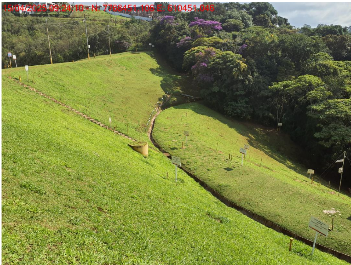
Figura 16: Vista parcial do talude de jusante da barragem. Notar instrumentação existente.
