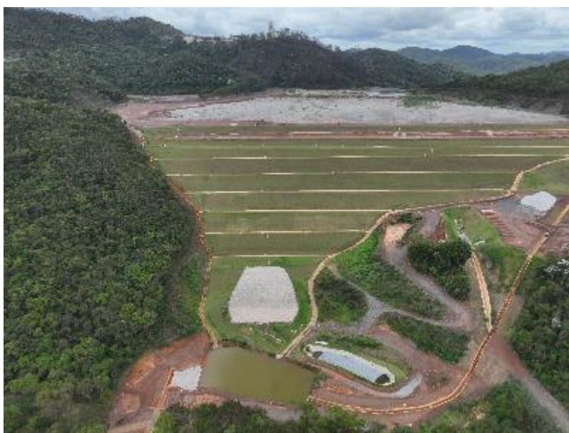
Figura 1: Vista aérea da Barragem de Rejeitos CDS II
