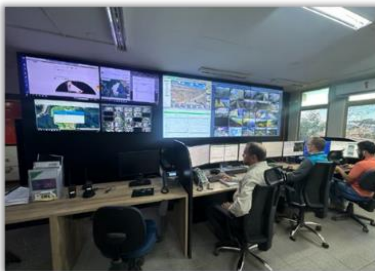
Figura 10: (CMG) Centro de Monitoramento Geotécnico de Barragens em operação.
