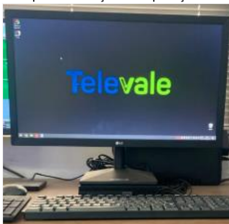
Figura 4: Exemplo da Estação de Operação Remota (EOR)
