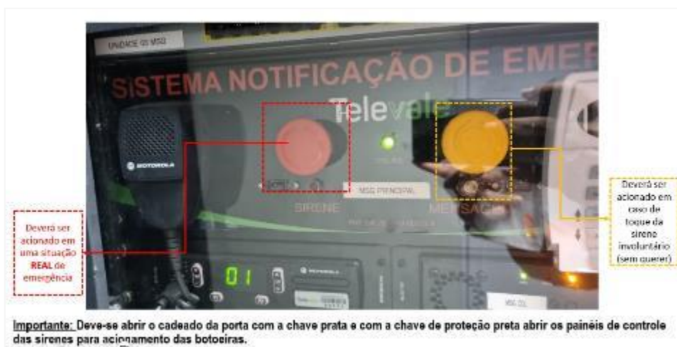
Figura 6: Central de Operação Local Externa Redundante (COL-R)
