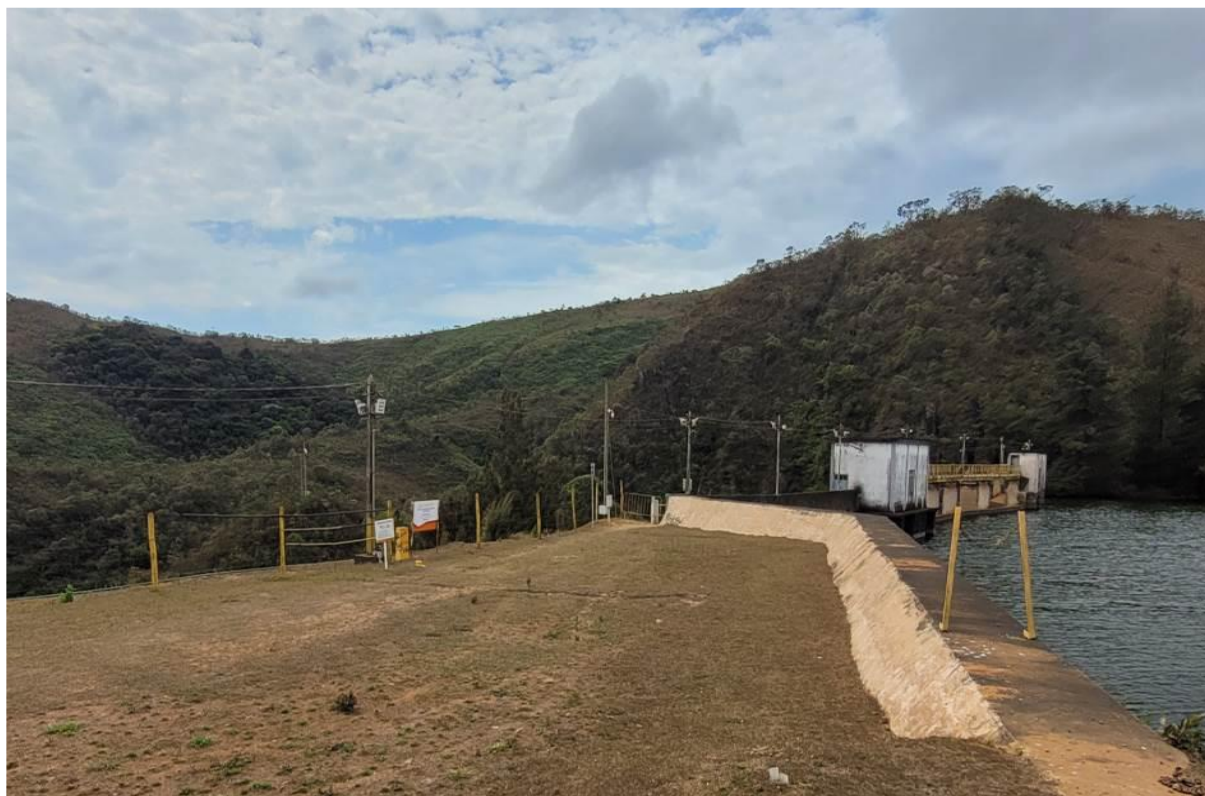
Figura 16: Vista parcial do talude de jusante da barragem. Notar instrumentação existente.
