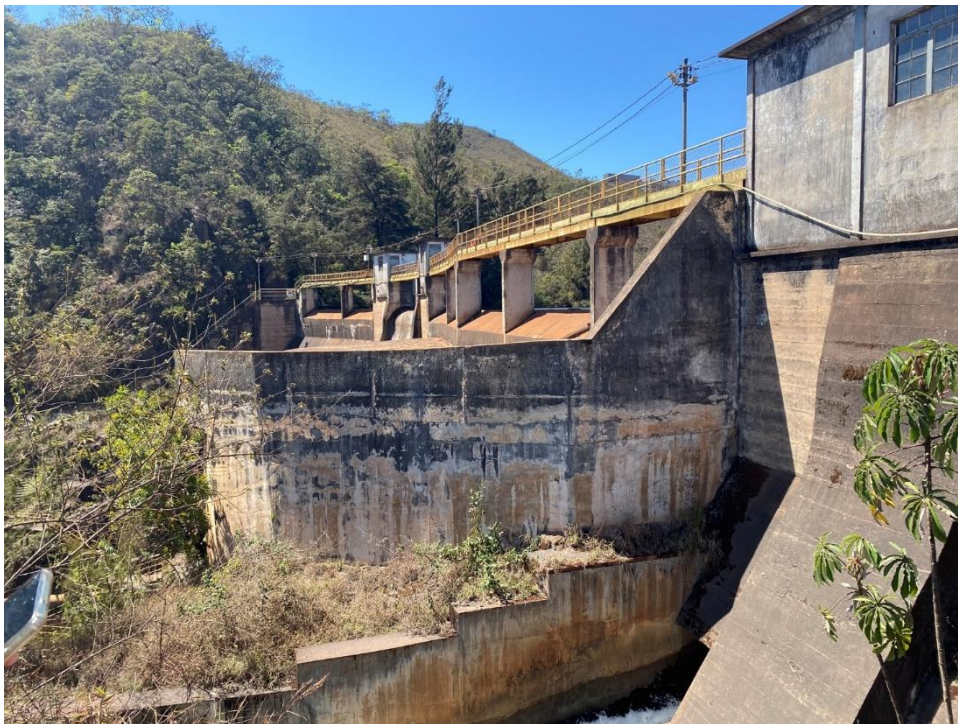
Figura 3 – Sistema extravasor da barragem Codorna.
