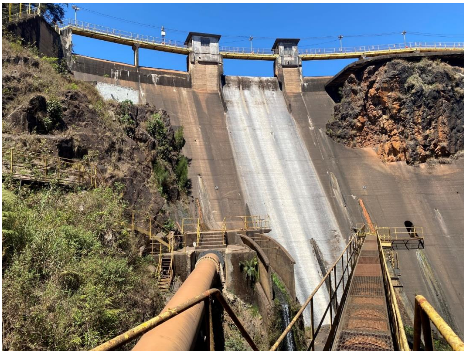
Figura 4 - Vista de jusante do sistema extravasor (soleira livre) da barragem Codorna.
