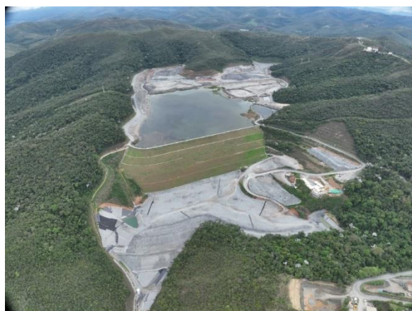
Figura 1: Vista aérea da Barragem Cuiabá
