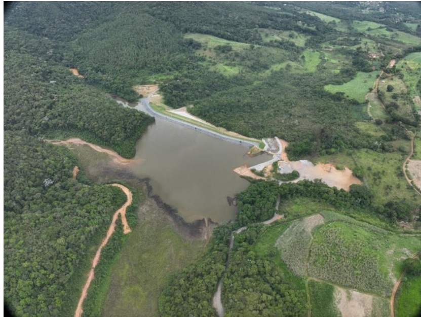
Figura 1: Vista aérea da Barragem de Finos CDS I
