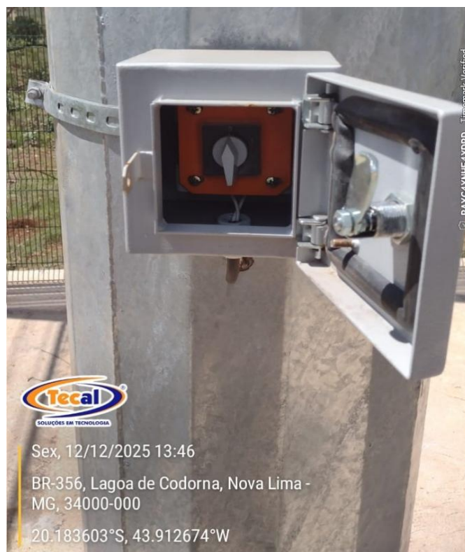
Figura 4: Botoeira de Acionamento Manual Torres Tecal
