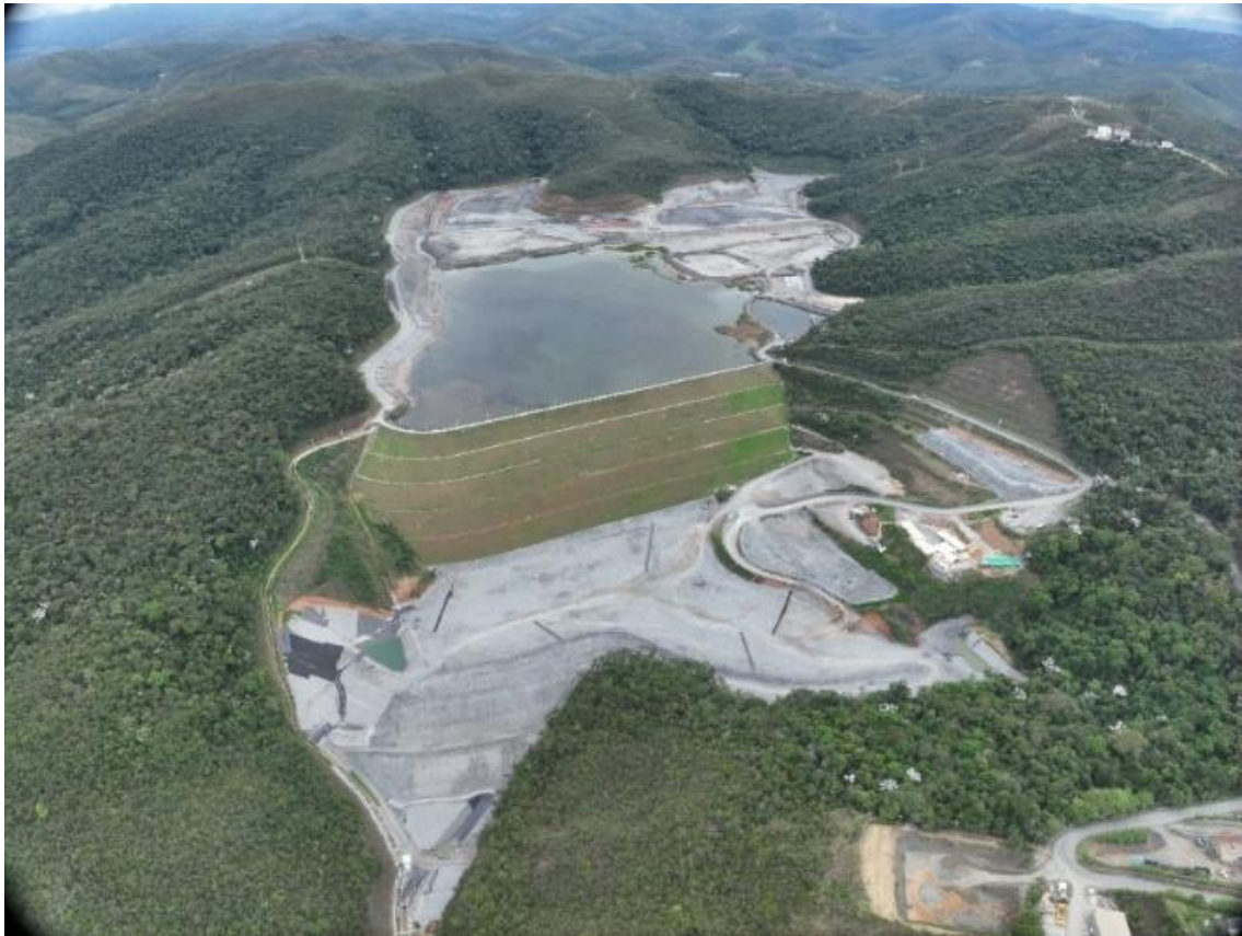
Figura 1: Vista aérea da Barragem Cuiabá
