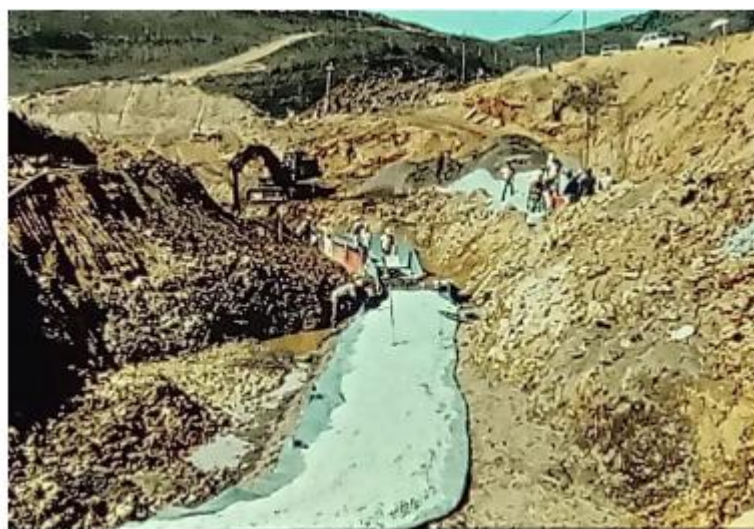
Figura 6.3 - Construção do sistema de dreno de fundo (Elcio Barbosa) (AGA, 2024).
