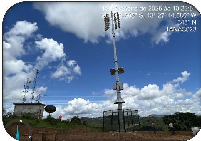
Visão da área onde está instalada a Estação Remota ER-25, Estação de Transmissão e ponto de monitoramento de água subterrânea
