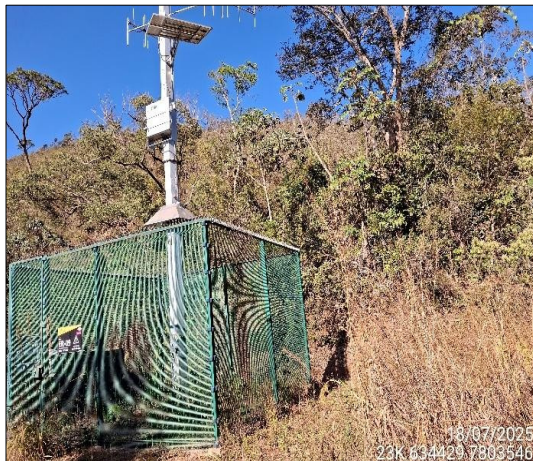
INSERÇÃO 6-206 - Área de estrutura operacional. Fonte: P3N Projetos Ambientais, 2025
