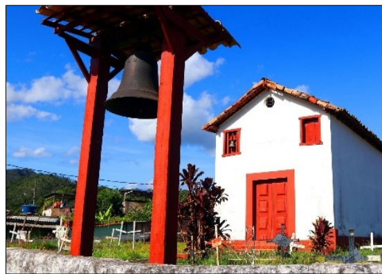
INSERÇÃO 6-431 - Capela de Santo Antônio do Pompéu
