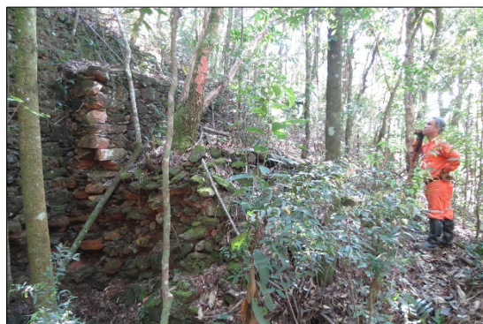
INSERÇÃO 6-516 - Muro de Pedras do Sítio Morro da Mina
