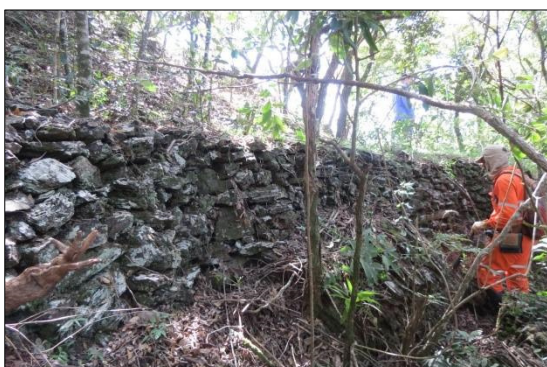
INSERÇÃO 6-515 - Muro de Pedras do Sítio Morro da Mina
