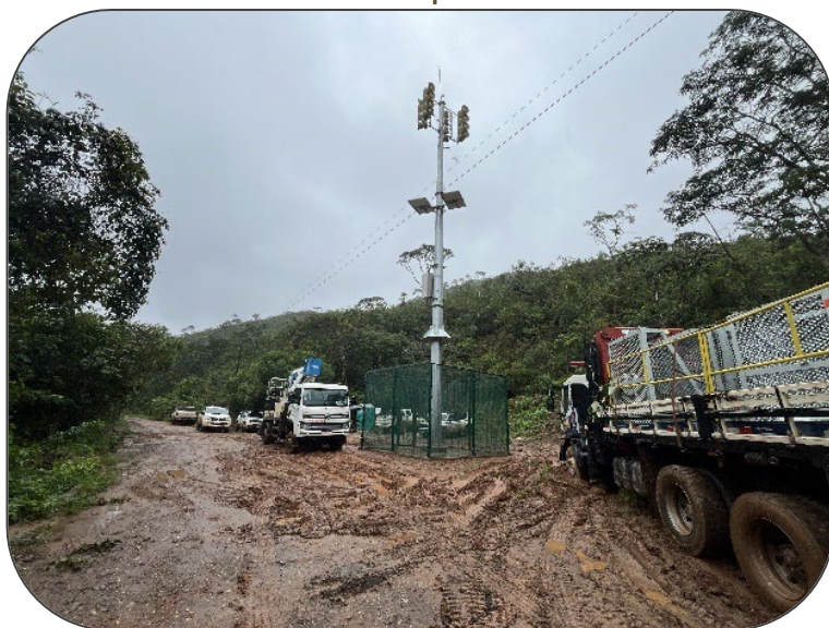
Área de estrutura operacional ER-9A
