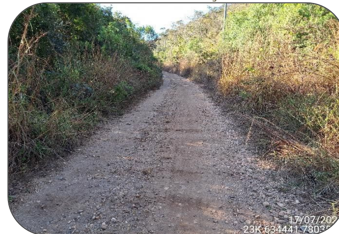
Via de acesso na área de intervenção da torre ER-09A
