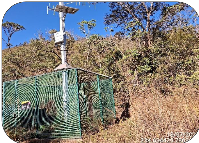
Aspecto geral da Estrutura Operacional da ER-09A
