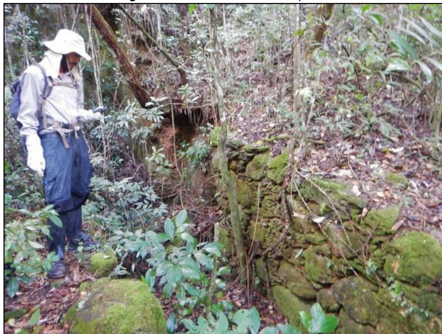
Figura 15 – Canal e arrimos de pedra
