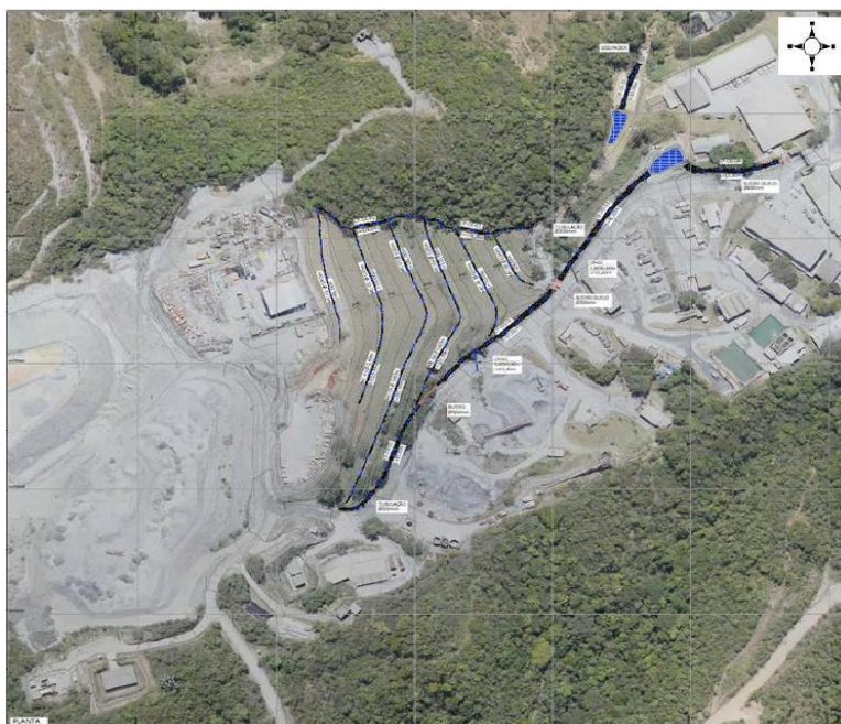
Figura 10 - Pilha de estéril de Lamego com foco no sistema de drenagem superficial
