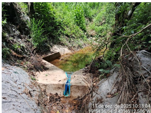
Figura 60 – Vazão do dreno de fundo e dique de contenção a jusante da PDE Lamego existente - dezembro de 2025 Fonte: Tema Ambiental, 2026.
