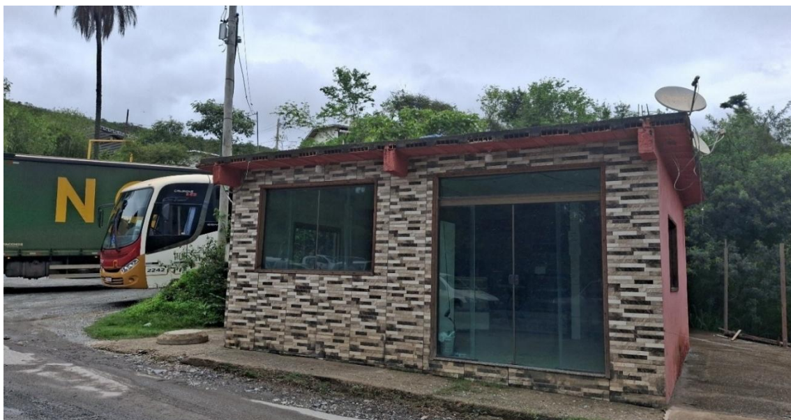
Figura 8 - Edificação adjacente à portaria da Mina Lamego
