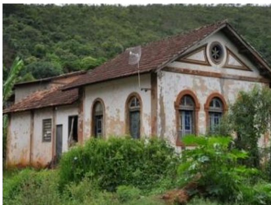
Figura 12. Casa do agente da estação em Honório Bicalho, Nov/2009. Fonte: Estações ferroviárias do Brasil, 2025.
