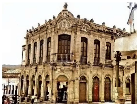
Figura 18. Casa Salles, datado de 1924 e demolido em 1978. S/d. Fonte: História de Nova Lima, 2025.
