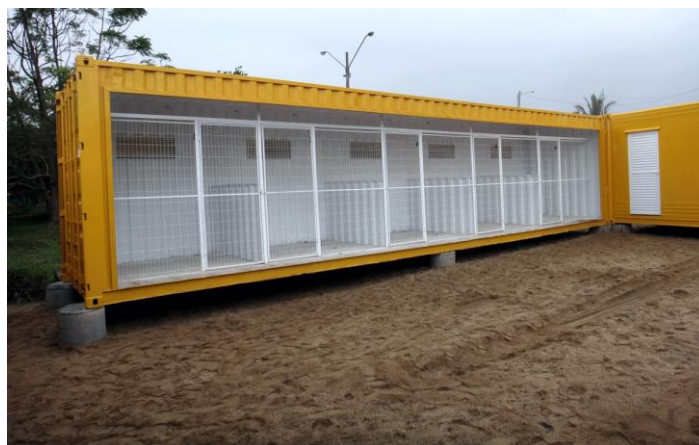
Figura 15: Contêiner canil, para abrigo e internação. Fonte: Evolution Contêiners. Data:
