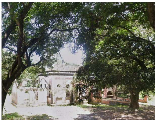
Foto 1. Vista externa do imóvel. Fonte: Google Maps, 2025.
