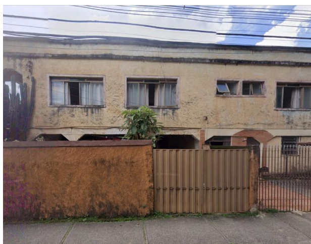
Foto 1. Vista externa do imóvel. Fonte: Google Maps, 2025.
