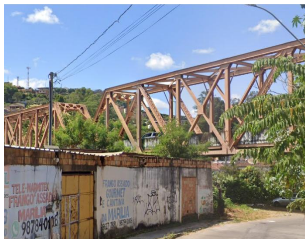
Foto 2. Vista lateral do pontilhão. Fonte: Google Maps, 2025.
