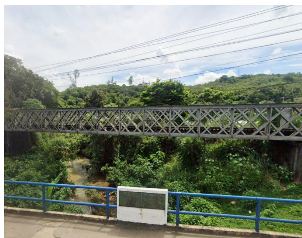
Foto 2. Vista lateral do pontilhão. Fonte: Google Maps, 2025.
