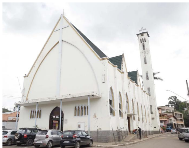
Foto 2. Vista da Igreja de Santo Antônio. Fonte: Google Maps, 2025.
