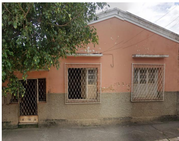
Foto 1. Vista externa do imóvel. Fonte: Google Maps, 2025.
