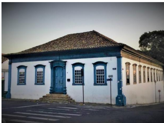
Figura 54. Vista Solar Teixeira da Costa. S/d. Fonte: Prefeitura de Santa Luzia, 2026.
