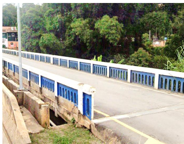
Foto 2. Ponte Rio Acima em concreto armado. Fonte: Google Maps, 2025.
