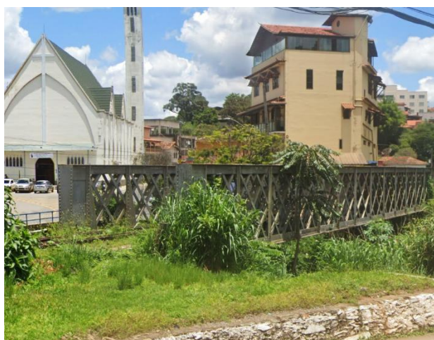
Foto 1. Vista do pontilhão. Fonte: Google Maps, 2024.
