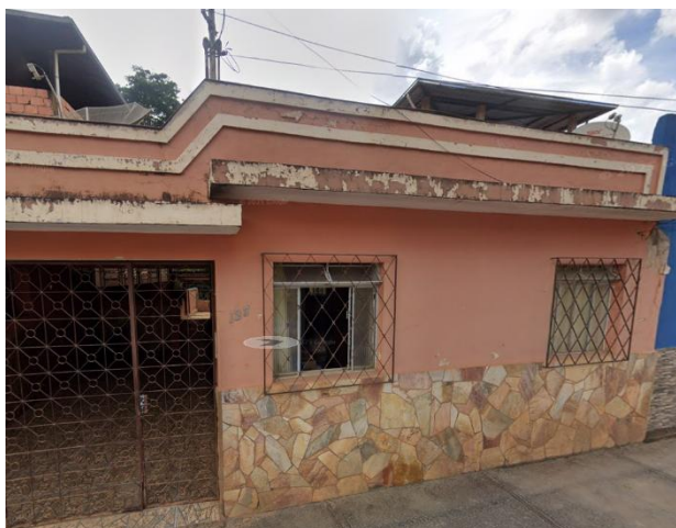
Foto 1. Vista externa do imóvel. Fonte: Google Maps, 2025.
