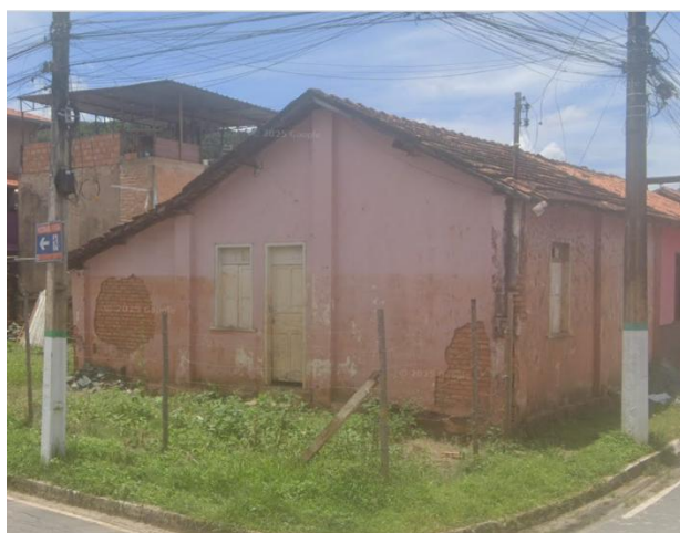
Foto 1. Vista externa do imóvel. Fonte: Google Maps, 2025.
