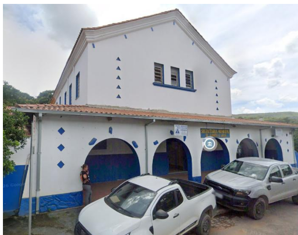
Foto 2. Fachada frontal da edificação. Fonte: Google Maps, 2025.
