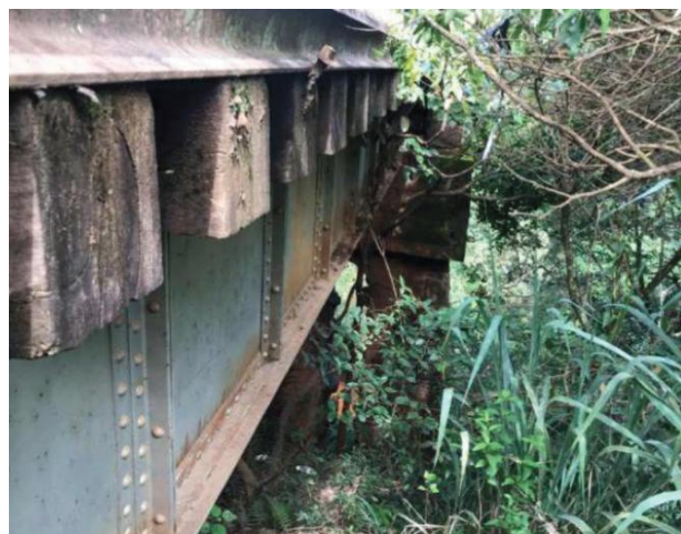
Foto 2. Estrutura da ponte. Fonte: PAE – Barragem Maravilhas II. VALE, 2023.
