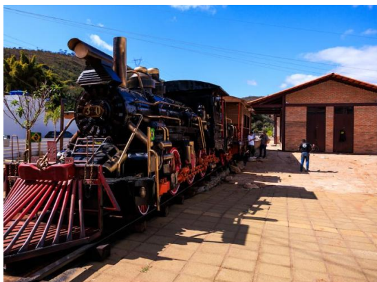
Figura 17. Reconstrução da antiga estação ferroviária de Honório Bicalho, Set/2025. Fonte: Diário do comércio, 2025.
