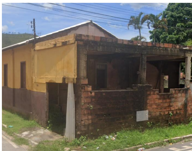
Foto 1. Vista externa do imóvel. Fonte: Google Maps, 2025.
