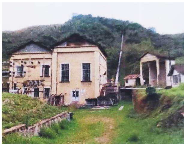
Foto 1. Casa de máquinas. Fonte: PAE – Barragem Maravilhas II. VALE, 2023
