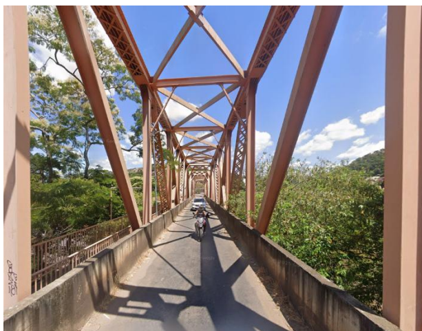
Foto 1. Vista do pontilhão cortando o rio das Velhas. Fonte: Google Maps, 2025.
