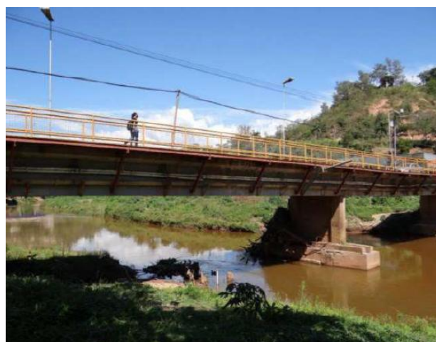
Foto 2. Vista lateral da ponte sobre o rio das Velhas. Fonte: PAE – Barragem Maravilhas II.
