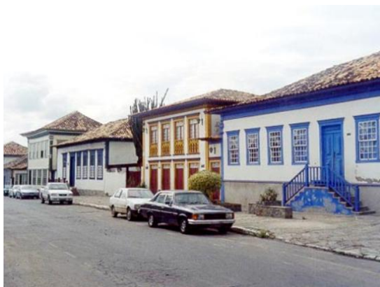
Figura 55. Conjunto de edificações da Rua Direita. S/d. Fonte: IEPHA, 2026.
