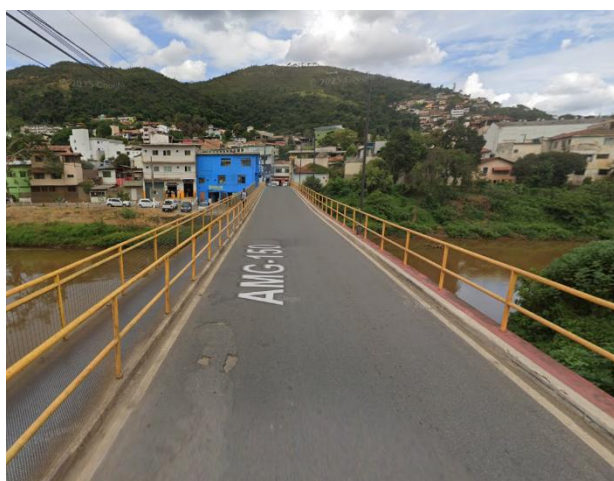
Foto 1. Vista da ponte sobre o rio das Velhas. Fonte: Google Maps, 2025.
