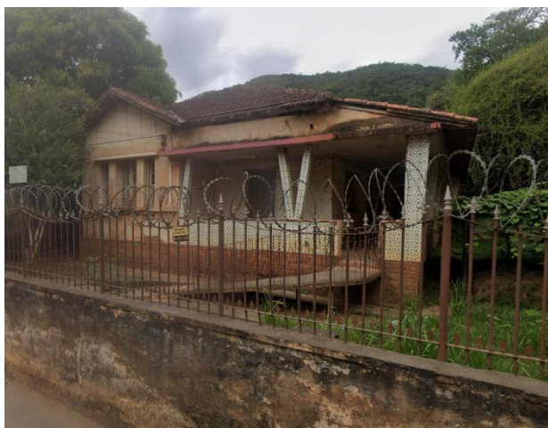
Foto 1. Vista externa do imóvel. Fonte: Google Maps, 2025.
