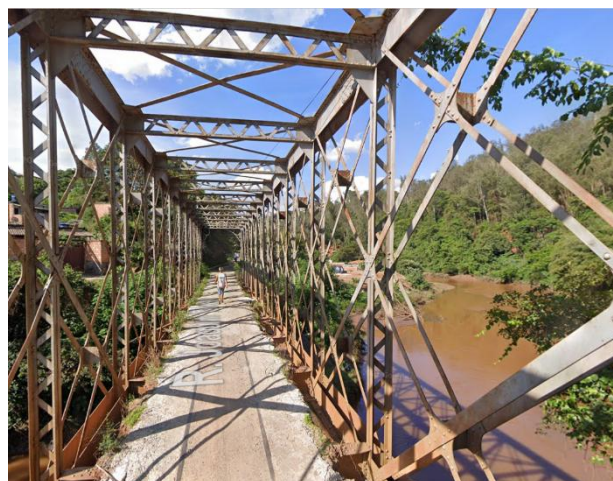
Foto 2. Detalhe da estrutura metálica da ponte. Fonte: Google Maps, 2025.
