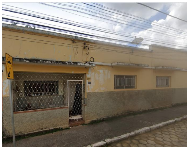
Foto 1. Vista externa do imóvel. Fonte: Google Maps, 2025.
